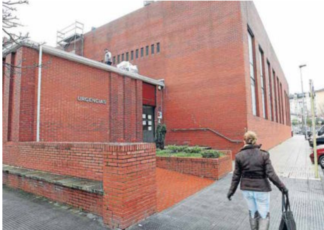
Edificio del Centro de Salud Zapatón, dónde también se pueden realizar las pruebas . / L.P.
